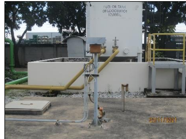
รูปที่ 10 Oil Separator และ Oil Alarm
