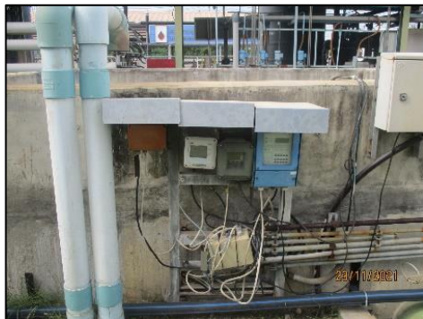
รูปที่ 11 ระบบ Online ของ Conductivity และ Temperature
